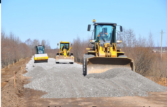
Ремонт дорог начался
